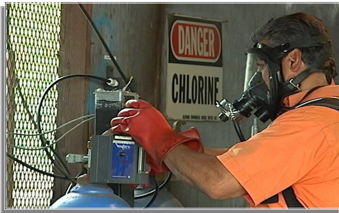
▲ تعویض کپسول کلر با زدن ماسک و دستکش
