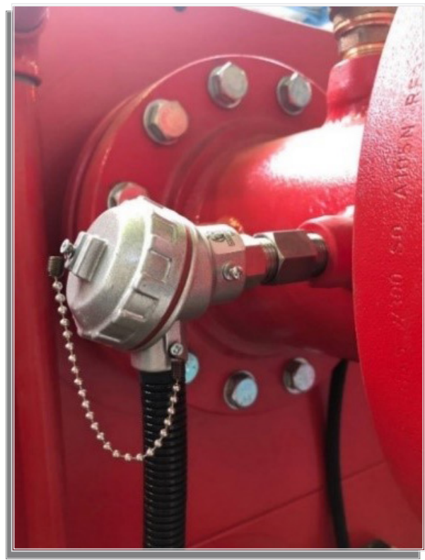
▲ سنسورهای نصب شده در ورودی بویلر
